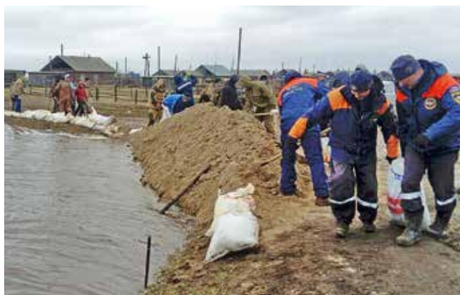
Временная дамба возводится с использованием местного грунта
